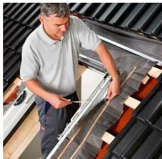
**Комплект для гидро- и теплоизоляции** для еще более простой и надежной установки мансардного окна. Комплект BDХ включает теплоизоляционный контур для утепления между окном и кровлей. Гофрированный гидроизоляционный фартук для герметичного соединения окна с гидроизоляцией кровли. Дренажный желоб отводит от окна воду, которая может проникнуть под кровельный материал. Дренажный желоб и гидроизоляционный фартук можно купить отдельно в комплекте ВFХ 1000, если установка комплекта BDХ невозможна.
